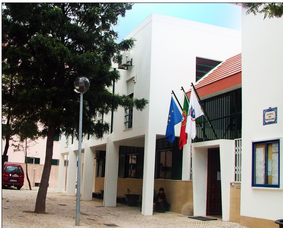
(Sede da Junta de Freguesia de Alcabideche)
