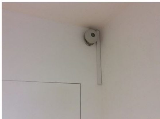
Montagem campainha EB MMRodrigues
