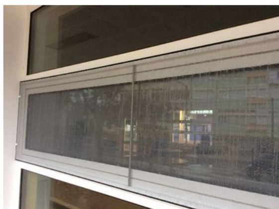
Colocação de mosquiteiros EB FT Lopes
