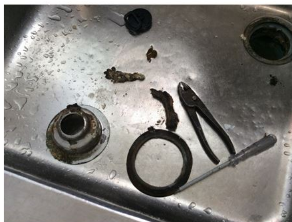
Lavatório na EB de Manique
