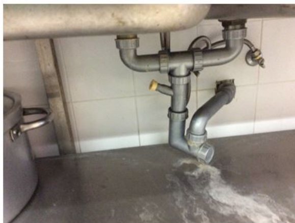
Reparação da canalização EB A Peça
