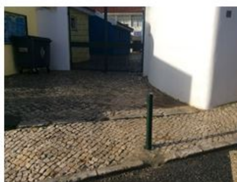
Colocação de pilarete
