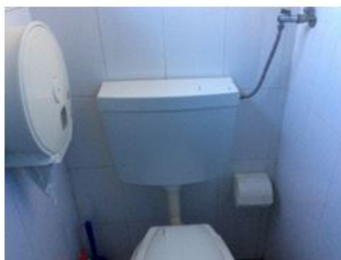
Substituição de equipamento
