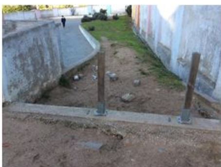
Reparação de vedação
