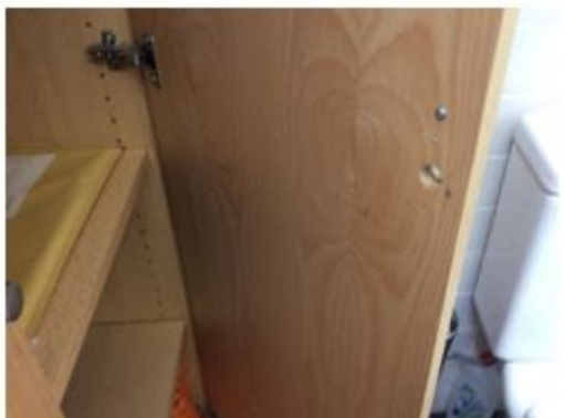
Intervenções em portas e torneiras
