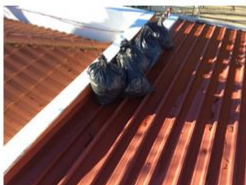
Limpeza de telhados
