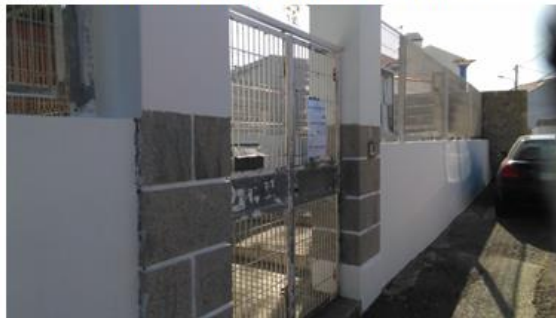
Pintura do Muro exterior da EB de Bicesse
