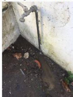
Intervenção em fuga de água na EB Fernando José dos Santos
