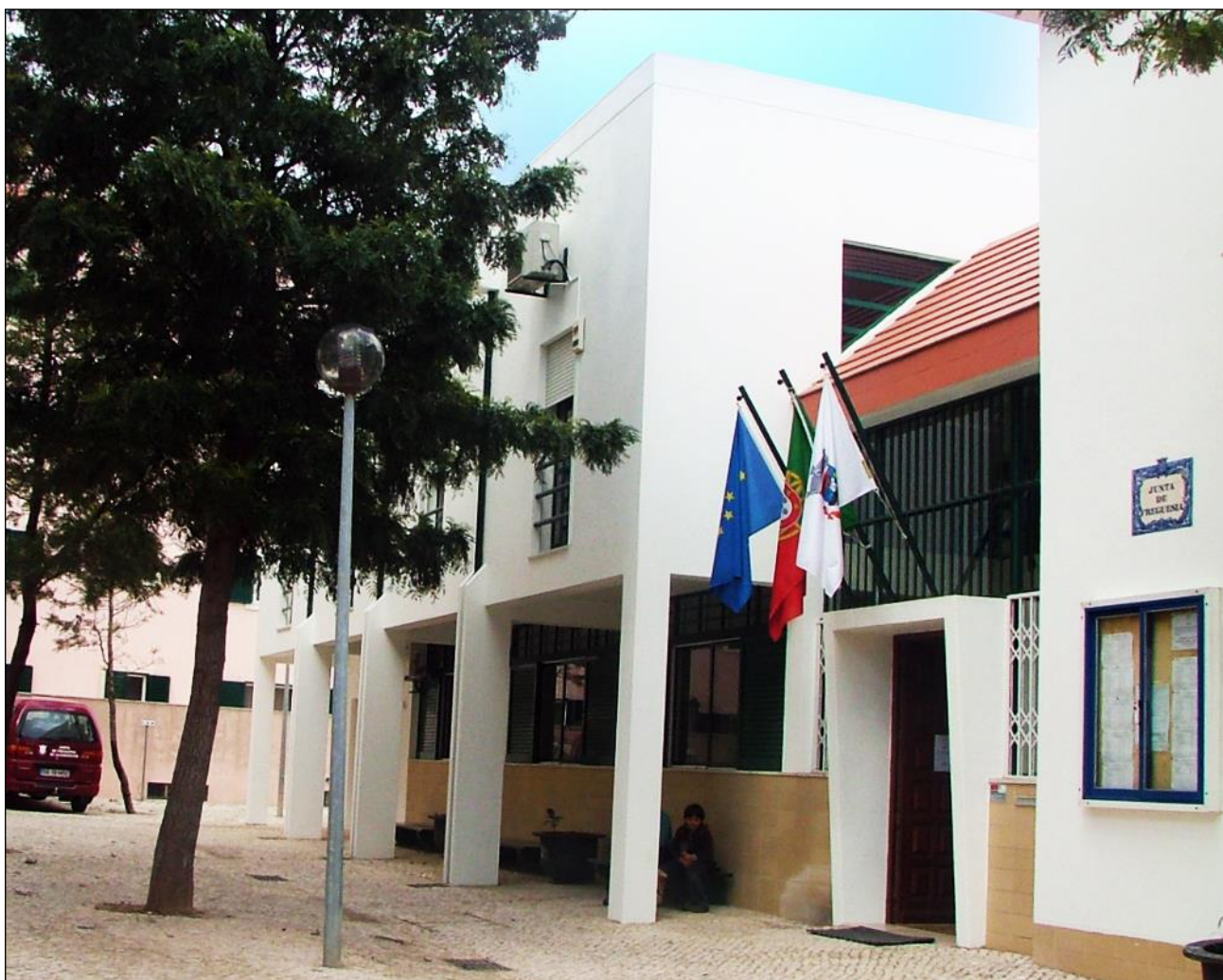
(Sede da Junta de Freguesia de Alcabideche)
