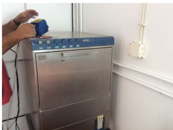
Montagem de Máq. Loiça na EB MMRodrigues
