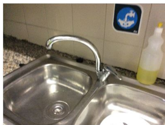
Instalação de torneira EB Bicesse
